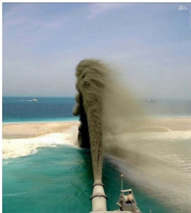
(شکل ۳): فرایند احداث جزایر مصنوعی
