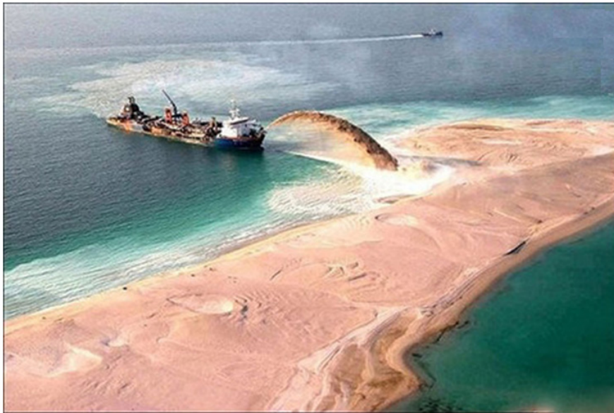
(شکل ۲): فرایند احداث جزایر مصنوعی
